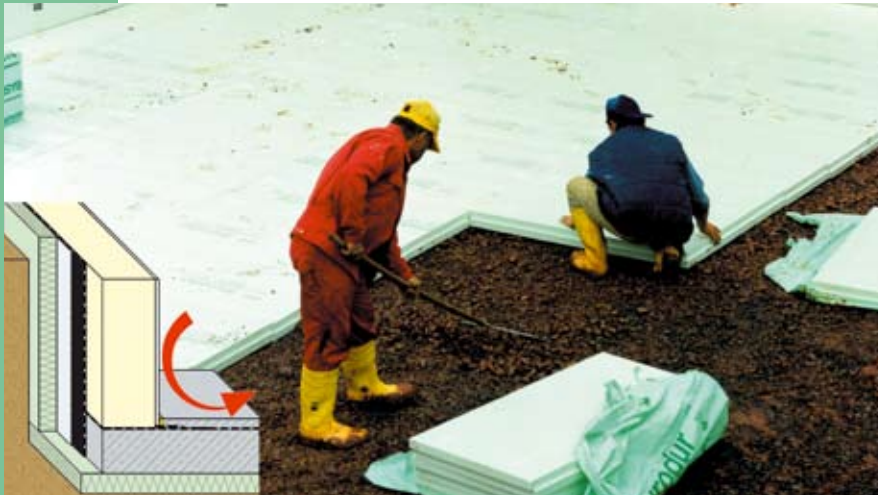
Eine um das Fundament geführte lastabtragende Kellerdämmung verhindert Wärmebrücken
